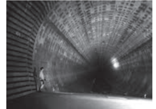
(写真左)2011(平成23)年8月26日の大雨で冠水した阿佐ヶ谷駅付近 (写真右)「神田川・環状七号線地下調節池」本体のトンネル。内径 12.5 m
